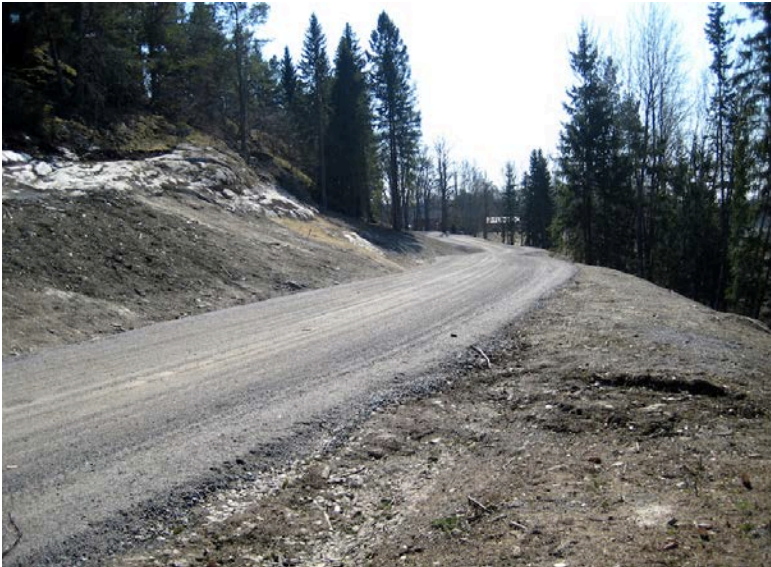
Den nyanlagda vägen genom området mot Källberga gård. Foto: Tema.
