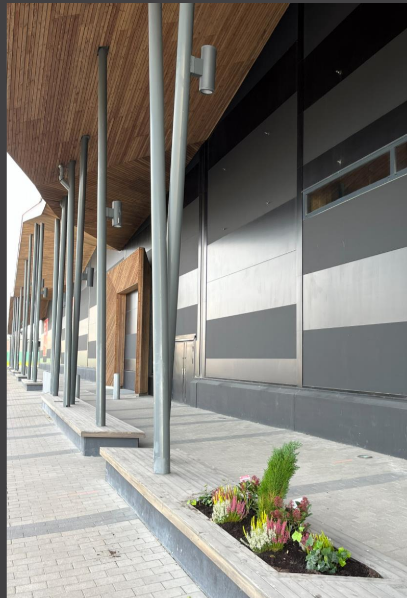
Mörkgrå plåtfasad med inslag av trä vid entré och undertak.
