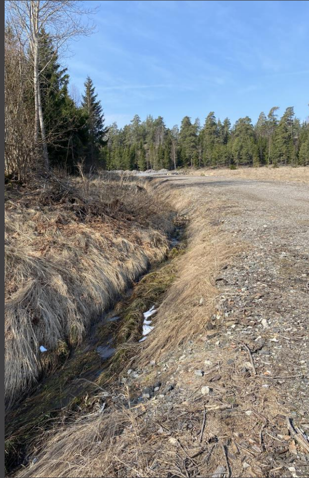
Angöringsväg och dike.
