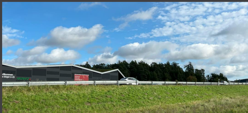
Mörkgrå plåtfasad mot skogsridå.
