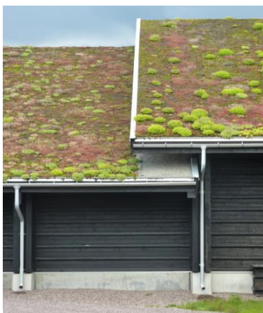
Figur 12. Sedumtak och stuprör med utkastare, källa WRS.
