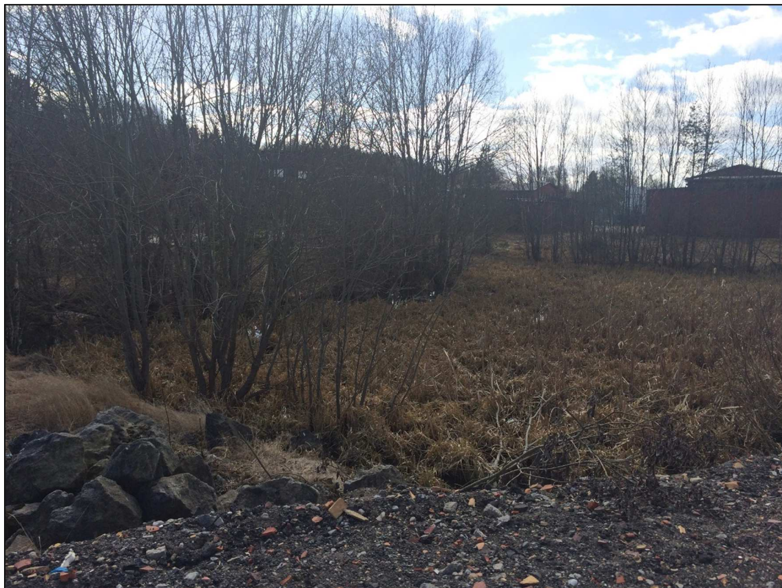
Figur 3:10 Dammanläggningen i korsningen Teknikervägen/Ingenjörsvägen.
