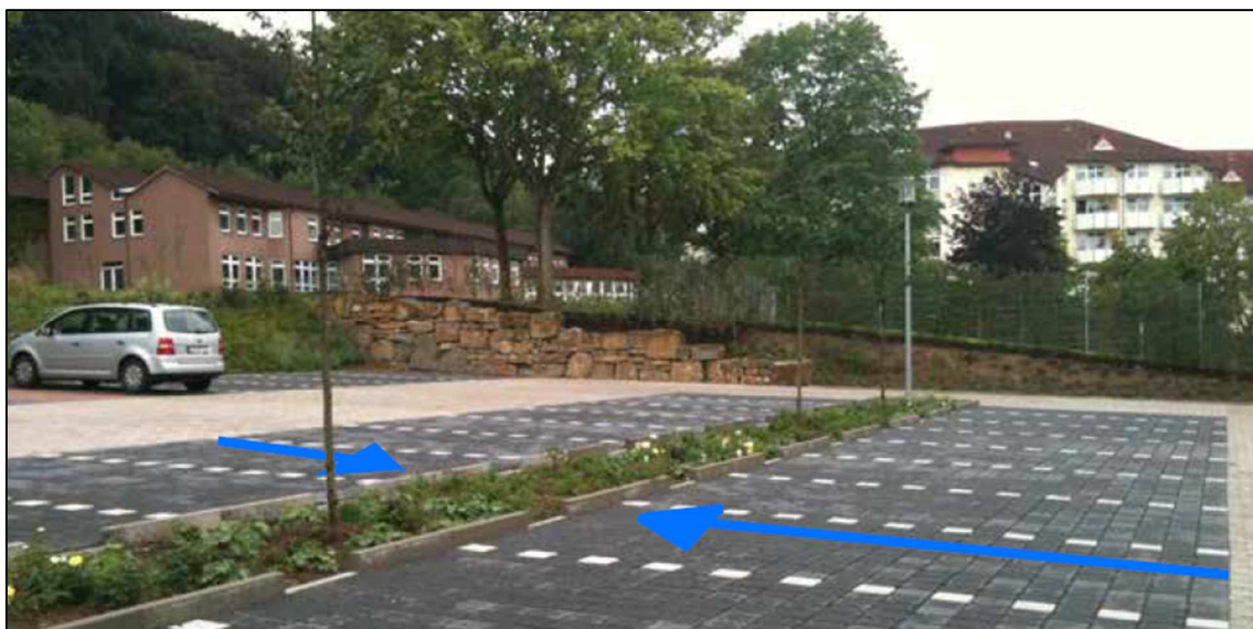
Figur 7:4. Exempelbild på infiltrationsstråk inom en parkeringsyta, från Uppsala Vattens exempelsamling för dagvattenhantering.
