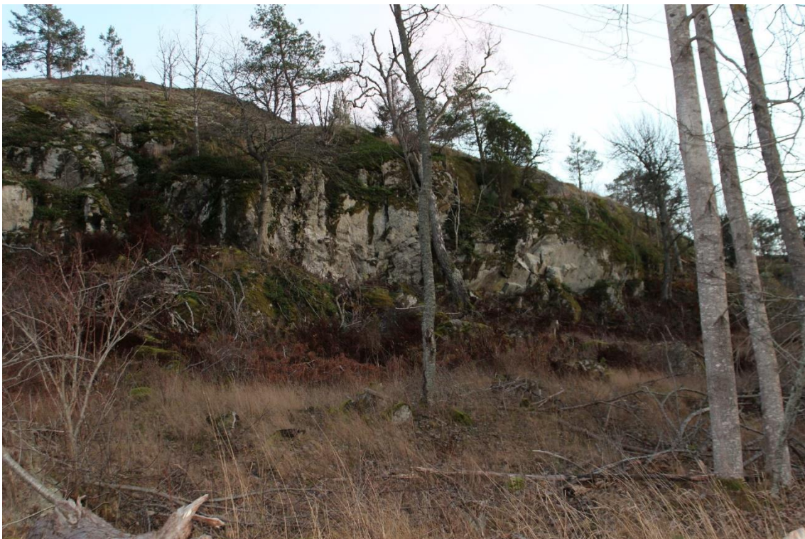
Figur 5. Bergslänt Läge 1, vy Södra delen.
