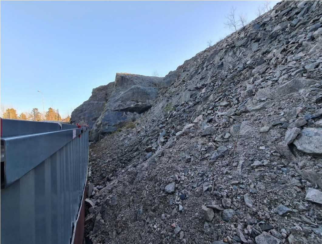
Figur 15. Blandad berg- och sprängstensslänt. Exempel på sten som rasat ut syns invid containern ned till vänster i bild. Vy mot sydost.
