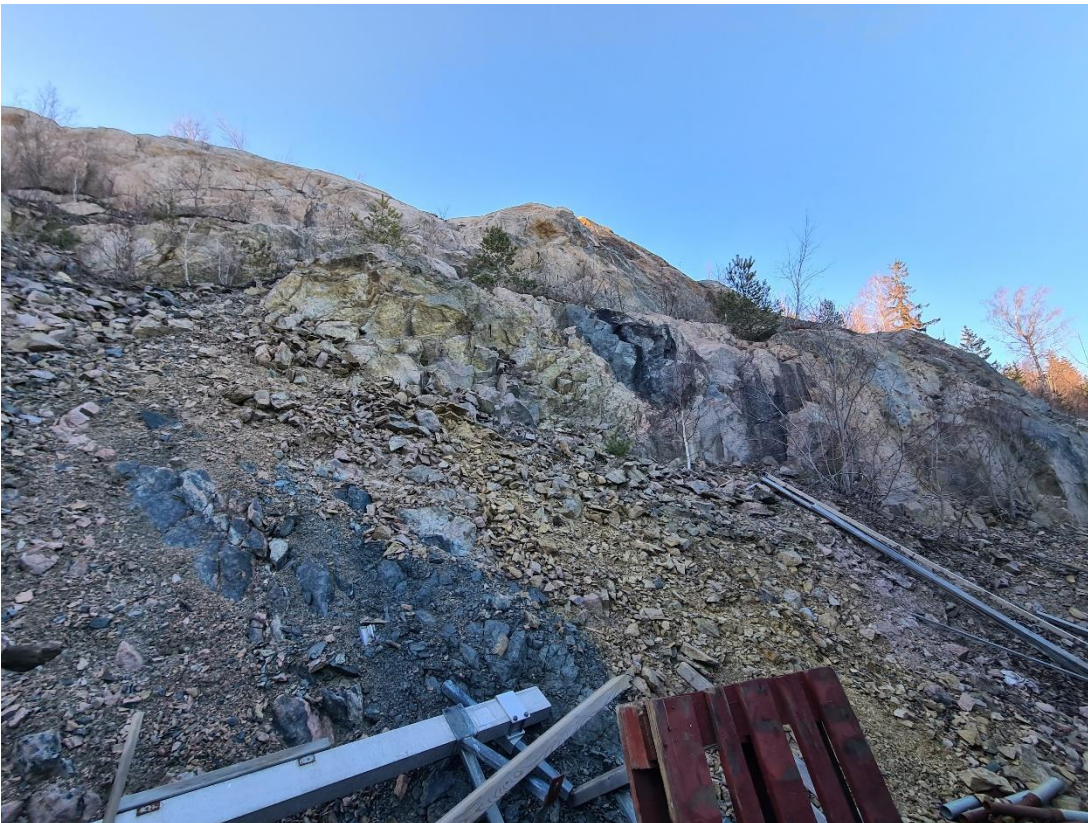
Figur 14. Bergslänt inom Läge 4 från vilken det kontinuerligt rasar mindre stenar in på Hantlangaren 1. Vy mot nordväst.
