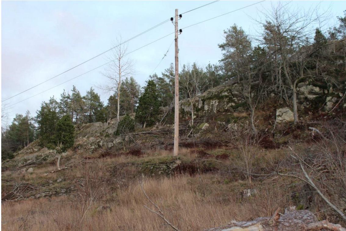
Figur 2. Bergslänt Läge 1, vy Norra delen. Huvudsprickriktning: Stupningsriktning ca 233-251°, stupningsvinkel 75-86°
