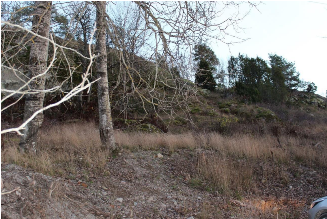
Figur 4. Bergslänt Läge 1, vy Södra delen.
