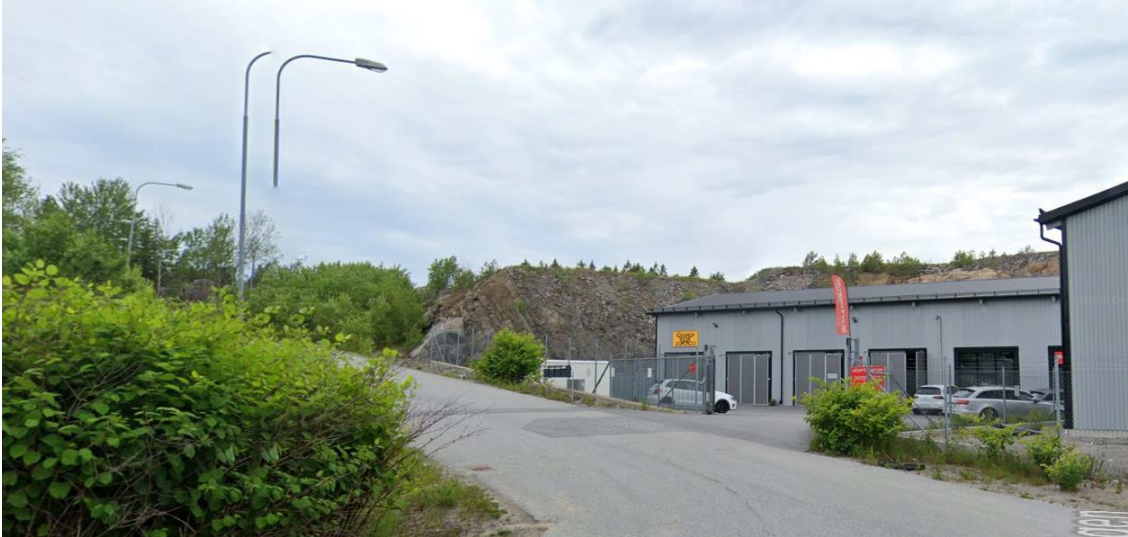
Figur 13. Läge 4. (Google Maps), berg som stupar inne på fastigheten Nynäshamn Hantlangaren 1.
