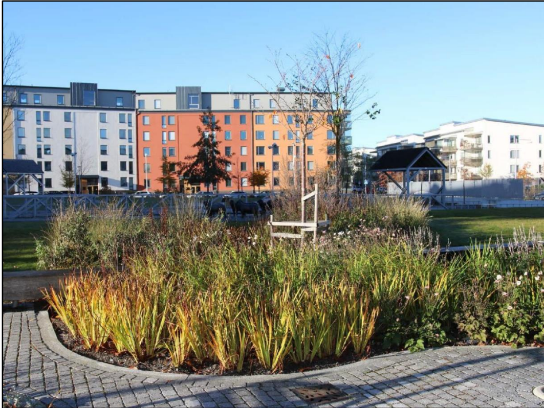
Figur 6.3. Exempel på nedsänkt växtbädd (Solna stad dagvattenstrategi, 2019).
