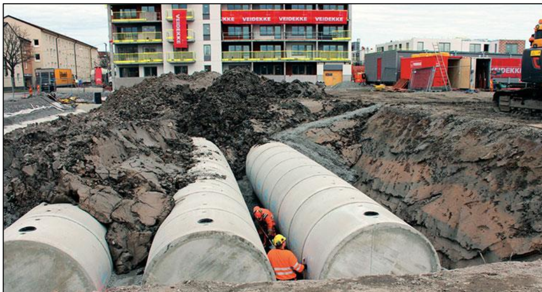
Figur 6:2 Exempel på utjämningsmagasin från Meag VA-system.
