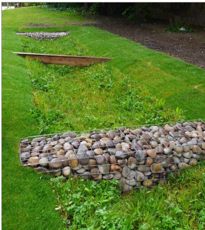
Figur 7.3. Exempel på dämmen i ett svackdike.
