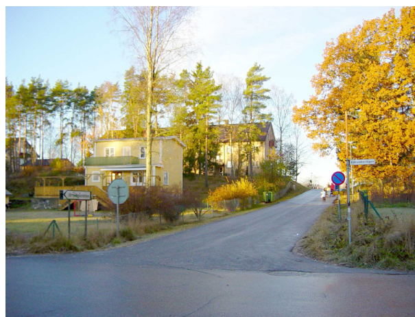
Korsningen mellan Körundavägen och Stationsvägen
