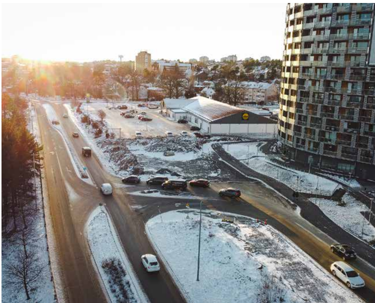
Arbetet med bygget av en cirkulationsplats vid området vid Sjötelegrafan har påbörjats.
