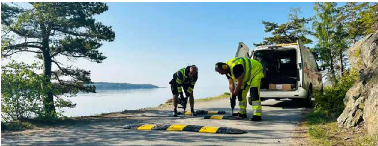
Farthinder monteras på Strandvägen.
