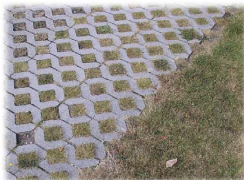
Parkeringsyta med hålsten av betong
