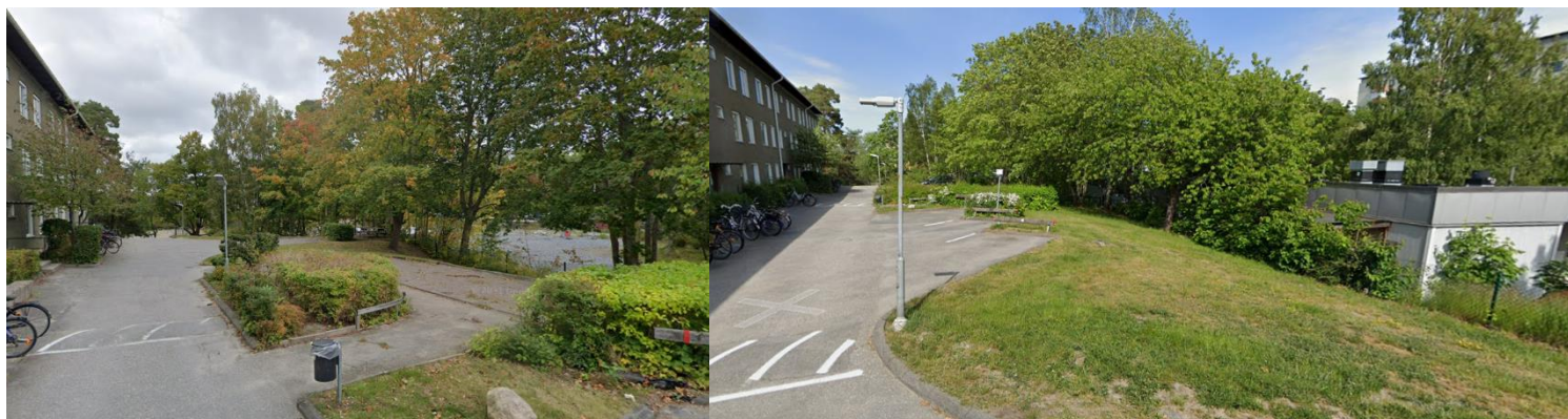
Figur 6: Vy från närliggande bostadsbebyggelse mot tillkommande radhus, före och efter rivningen av Humelgårdskolan, 2021 vänster 2019 höger.
