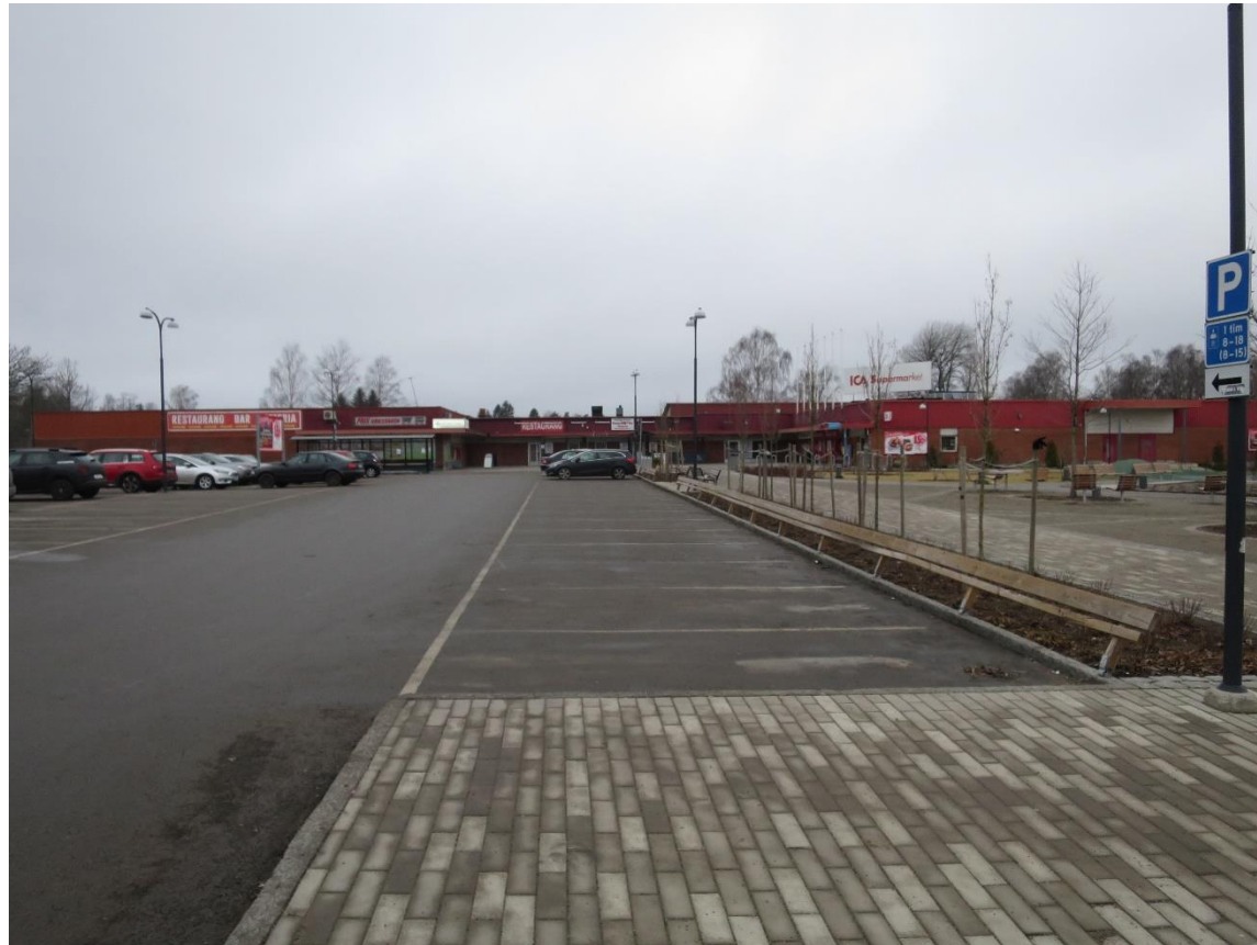
De låga butiksbyggnaderna från 1970-talet ligger i ena änden av det vidsträckta centrumområdet, och med god tillgänglighet för bilburna. Utemiljön har rustats upp under de senaste åren och simhallen i östra delen av centrum genomgår en utvändigt ansiktslyftning.
