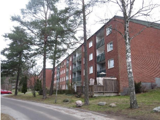
Bergsvägens flerbostadshus är uppförda enligt idealet om hus-i-park men har samtidigt en massiv verkan.
