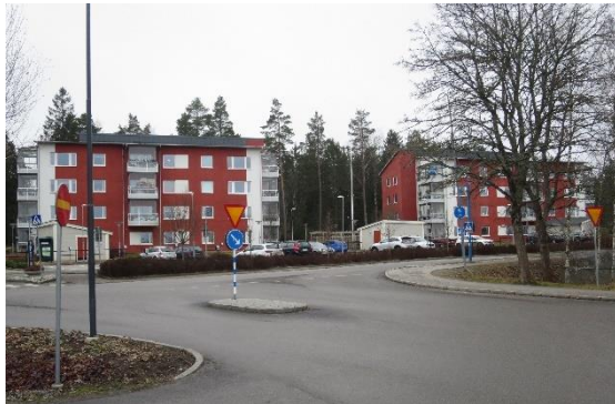
Flerbostadshusen från 2008 ligger indragna från gatan med parkering framför.
