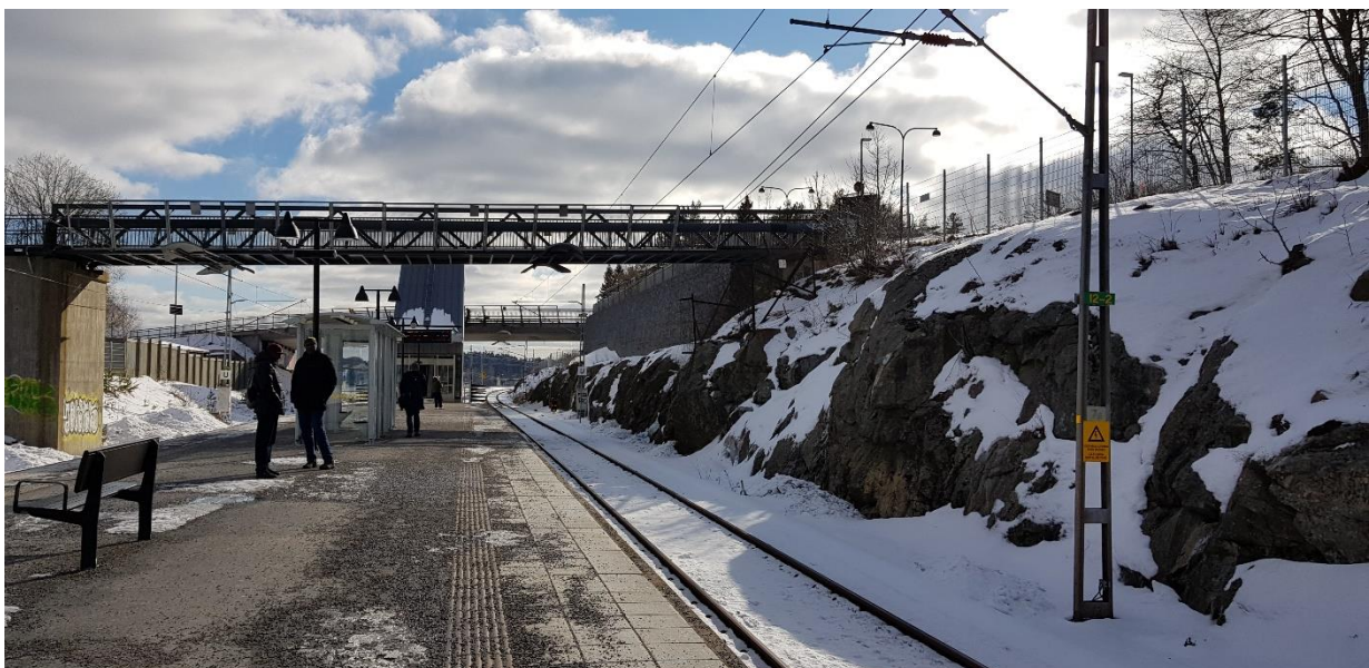
Figur 8. Bild som visar den naturliga bergsväggen mellan spårområdet och planområdet, tagen från Ösmo pendeltågsstation i sydvästlig riktning.
