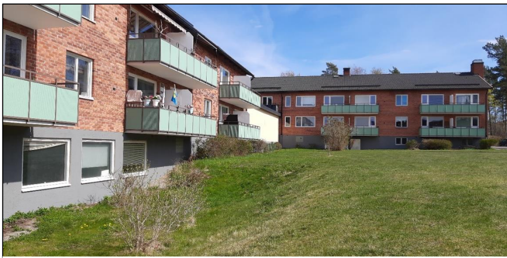
Figur 3:4. Befintliga byggnader som kommer att bevaras, tillsammans med lokal lågpunkt, till vänster i bild. Fotografi från platsbesök 2022-05-04.
