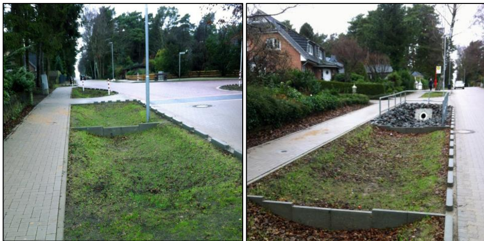
Figur 7:8. Exempel på dämmande sektioner (Stockholm Vatten och Avfall, 2022a).
