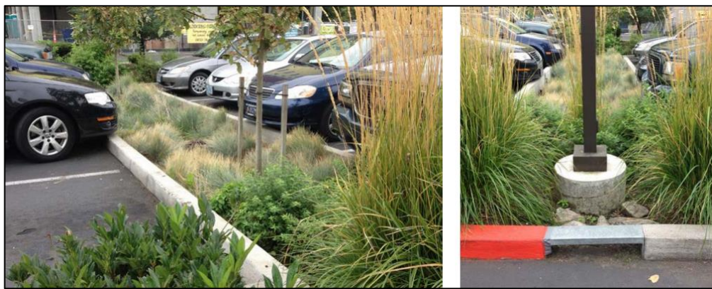
Figur 7:2. Exempelfoto på regnbäddar i gatumiljö där dagvattnet leds in i regnbädden via öppningar i kantstenen (Stockholm Vatten och Avfall, 2022b).
