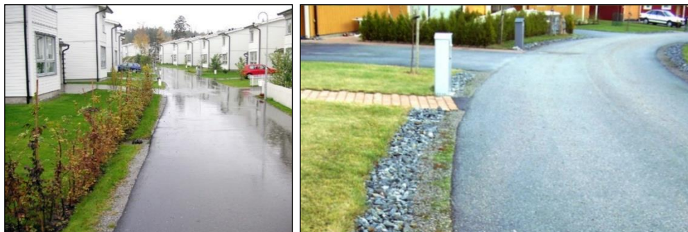
Figur 7:5. Exempel på utformning av hantering av dagvatten med grusade infiltrationsstråk (Stockholm Vatten & Avfall, 2022c).
