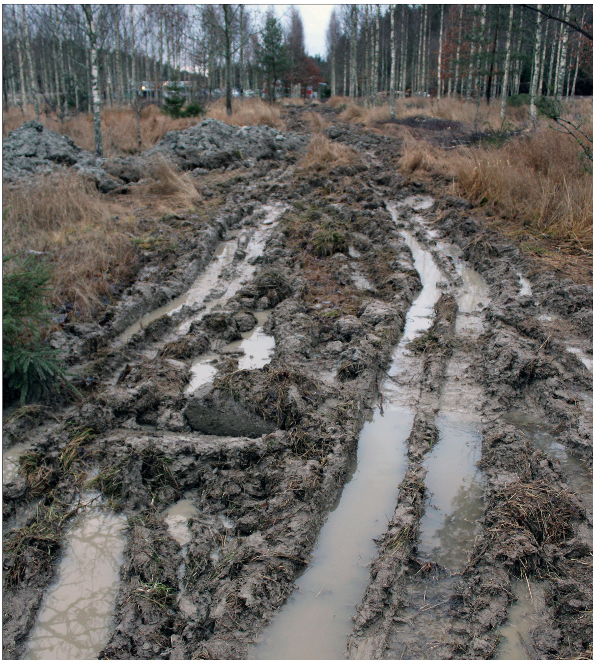
Figur 5. I den östra delen ansamlades mot slutet stora mängder vatten vilket begränsade grävmaskinens framkomlighet. Foto från norr.
