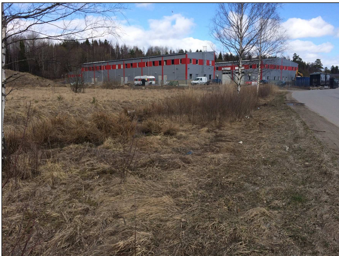
Figur 3:11 Öppen avledning av dagvatten längs Teknikervägen i planområdets södra del. Anläggningen utgörs av ett cirka 150 m långt dike med riklig växtlighet och låg strömningshastighet.
