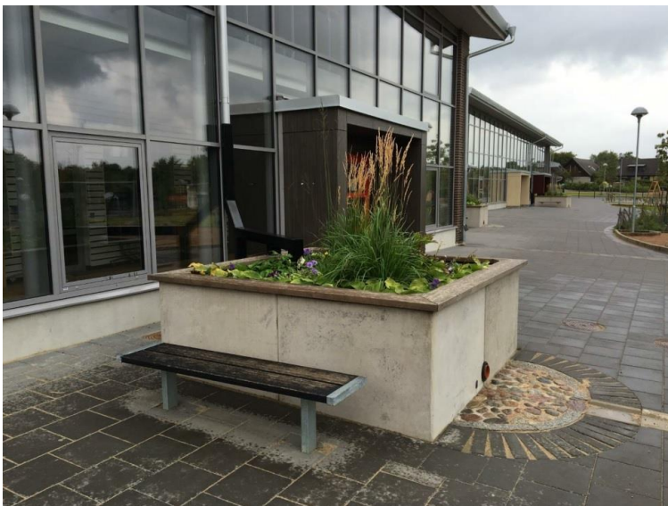
Figur 2 Växtbädd för rening och fördröjning av takvatten (Bildkälla: Kent Fridell)
