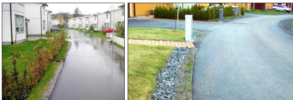
Figur 7:5. Exempel på utformning av hantering av dagvatten med grusade infiltrationsstråk (Stockholm Vatten & Avfall, 2022c).
