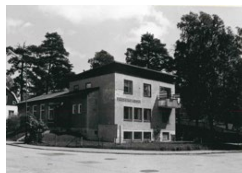
Figur 7: Befintlig huvudbyggnad, som den såg ut 1973 innan tilläggsisoleringen
